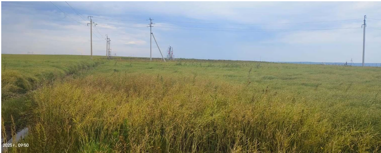
Рисунок 3 - Вид по трассе проектируемой ВЛ-10 кВ
