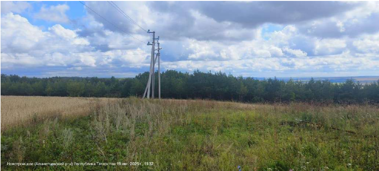
Рисунок 4 - Вид по трассе проектируемой ВЛ-10 кВ
