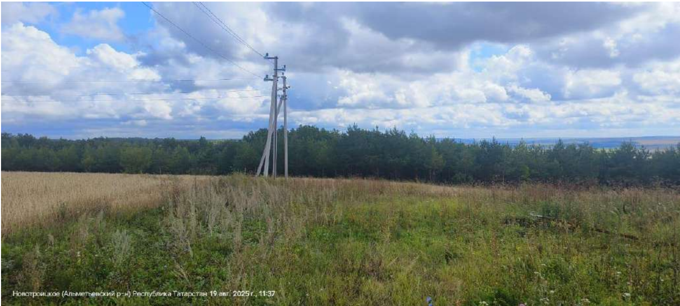
Рисунок 3 - Вид по трассе проектируемой ВЛ-10 кВ
