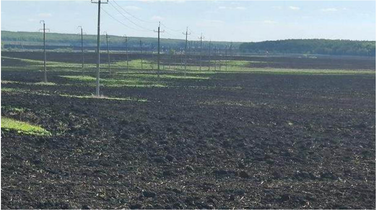
Рис. 3.1.4. Вид на трассу нефтегазосборного трубопровода от ГЗУ-6 до УПСВ-3, в районе ПК15 (отбор пробы почвы П-4)
