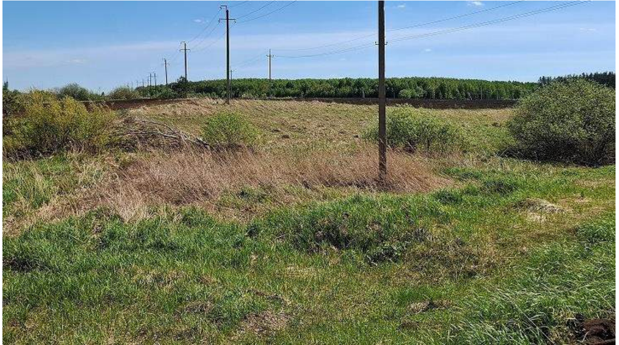
Рис. 3.1.8. Вид на трассу нефтегазосборного трубопровода от ГЗУ-6 до УПСВ-3, в районе ПК30+70 (отбор пробы почвы П-8)
