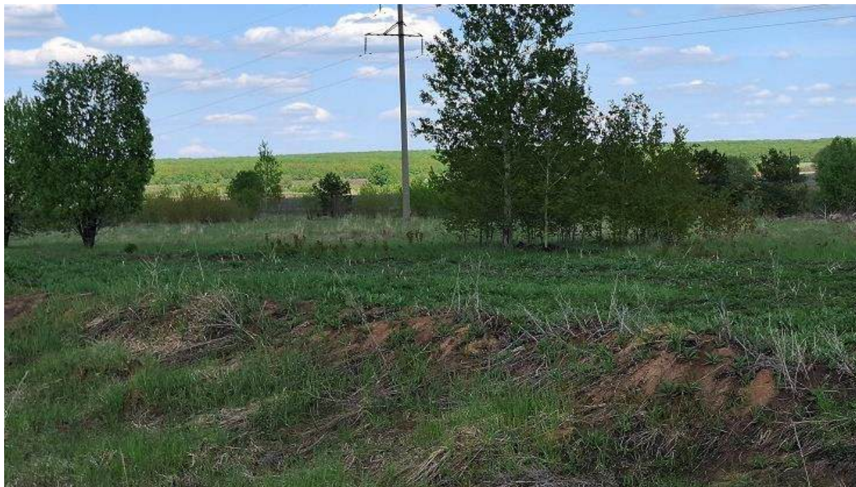
Рис. 3.1.12. Вид на трассу нефтегазосборного трубопровода от ГЗУ-6 до УПСВ-3, в районе ПК54+45 (отбор пробы почвы П-12)
