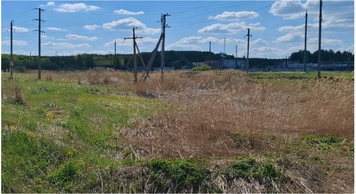
Рис. 3.1.13. Вид на трассу нефтегазосборного трубопровода от ГЗУ-6 до УПСВ-3, в районе ПК59 (отбор пробы почвы П-13)
